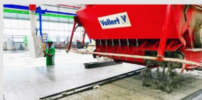
Distribuidor de hormigón/ compactación
